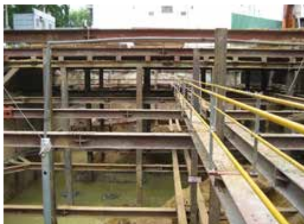
HỆ THỐNG GIẰNG CHỐNG HỐ ĐÀO
