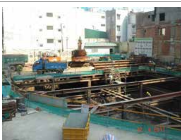
HỆ THỐNG GIẰNG CHỐNG HỐ ĐÀO
