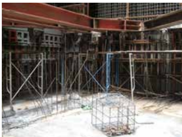
HỆ THỐNG GIẪNG CHỐNG TẠI VỊ TRÍ LỖI THANG TẦNG HẦM
